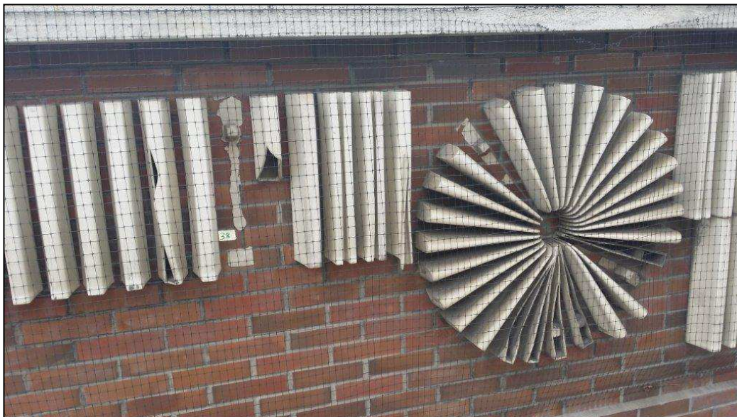
Ansicht rechts und unten: abgestürzte Teile, sowie keramische „Garnierungen“ und Fragmentierungen
