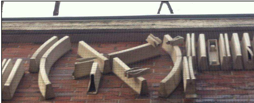
Ansichten vor der Restaurierung
