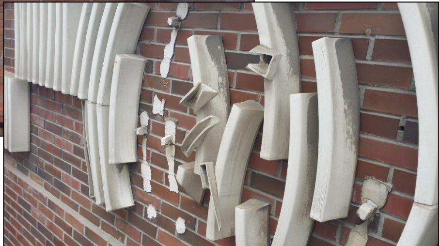
Ansicht rechts und unten: abgestürzte Teile, sowie keramische „Garnierungen“ und Fragmentierungen
