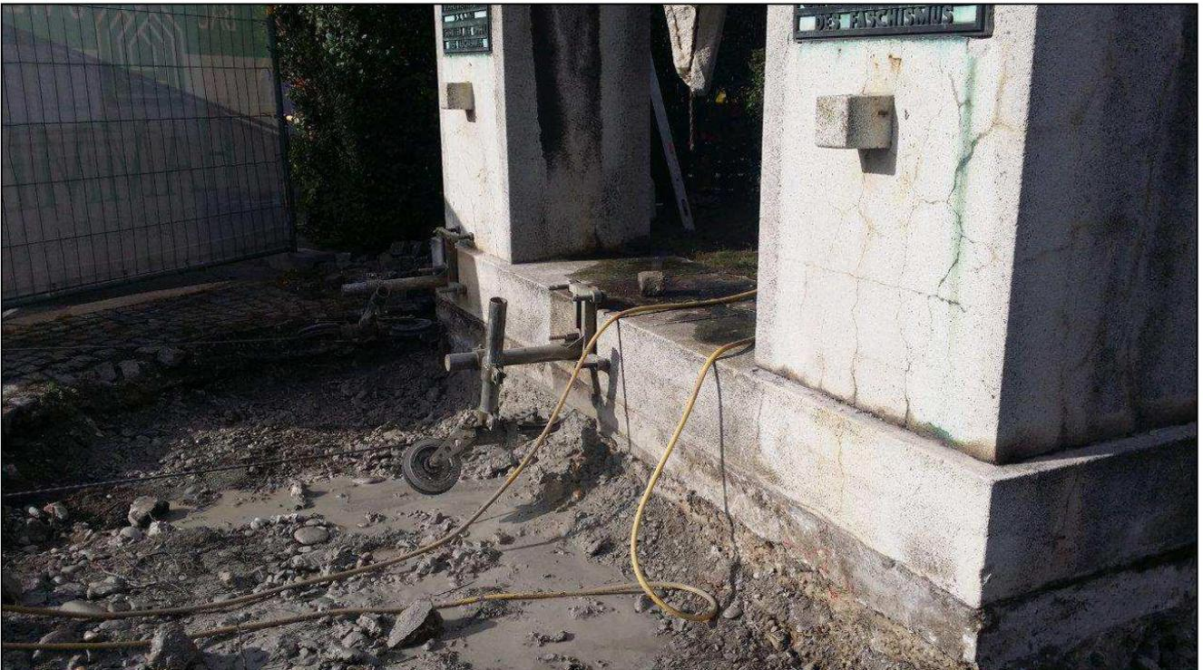
^ Trennen des Denkmals vom Fundament mittels Seilsage nach dem Entfernen der vorderen Sockelplatte
