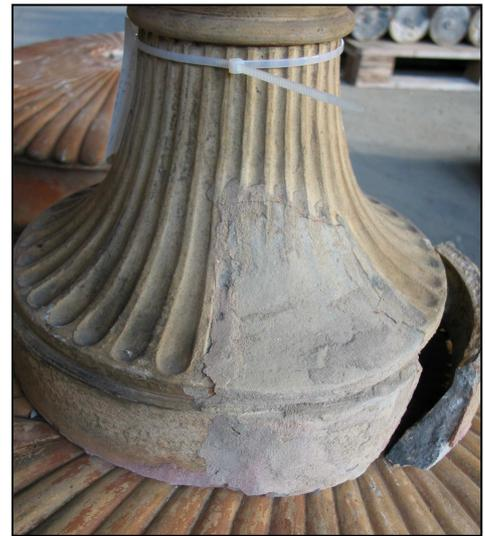
Schonendes Entfernen aller rezenter Mörtel- und Betonauffüllungen samt herausarbeiten von eingegossenem Armierungsmaterial (Stahl) aus den Objekten. Im Fall der Unmöglichkeit der Entfernung des Eisendorns (einige Kandelaber) wurde der Mörtel an den zugänglichen Bereichen entfernt und mittels Korrosionsschutz behandelt.
