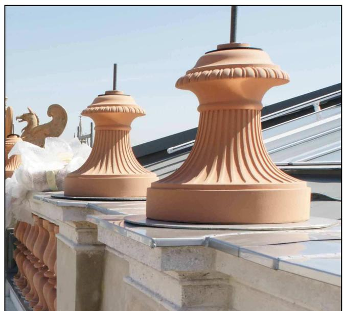
^ nach der Montage der Edelstahlkonstruktion wurden die Vasenfüße mit den Vasenschalen an den Postamenten fixiert:
