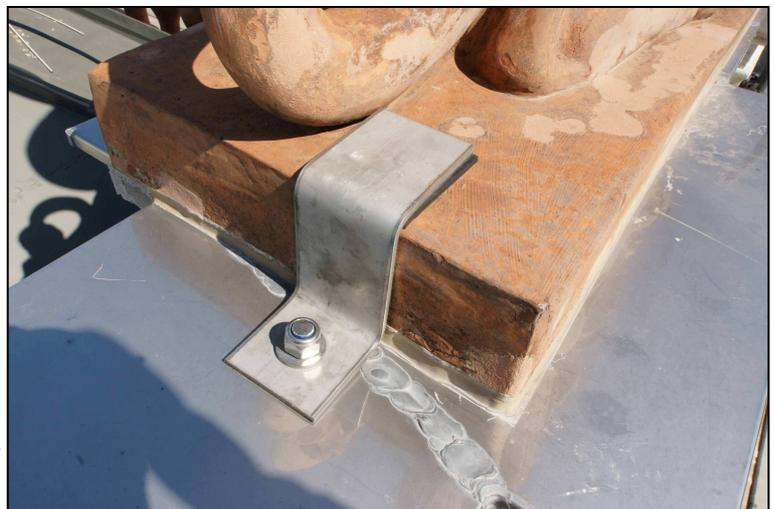
^ in der Schnittstelle zwischen Verblechung und Keramik kam elastisches Fugenmaterial zum Einsatz (*Innotec Adheseal beige*)
